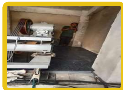
Pengerjaan Overhaul Lift
